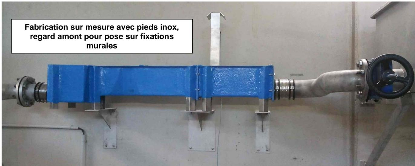
Fabrication sur mesure avec pieds inox, regards amont et
