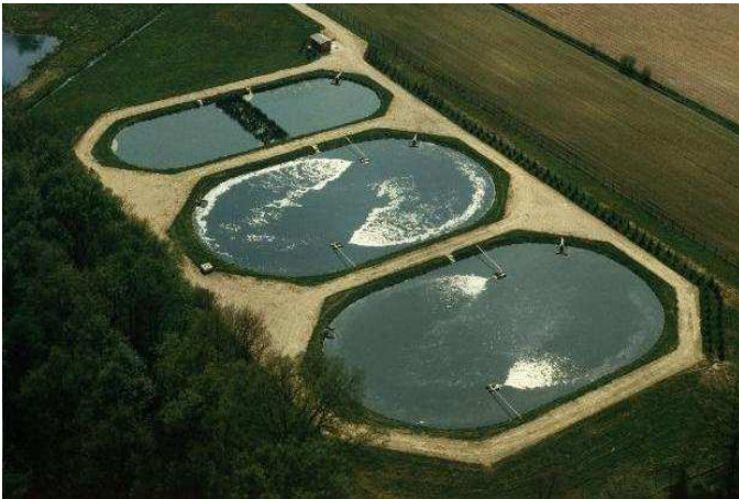
L'aérateur OxyStar génère un déplacement horizontal de l'eau
