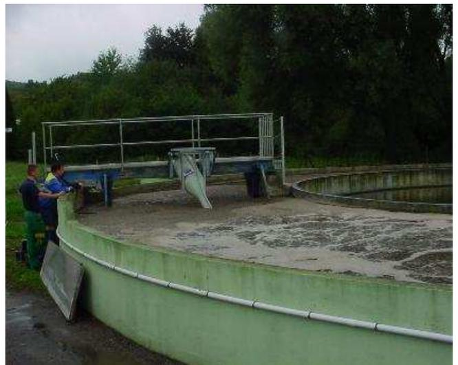
**Aérateur en remplacement d'un pont brosse
