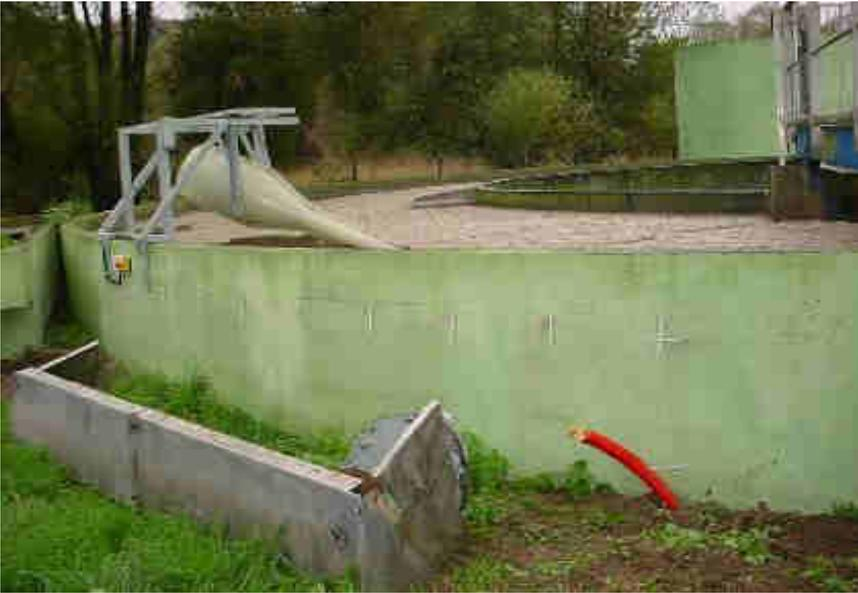
Montage sur suspension flottante à axe vertical
