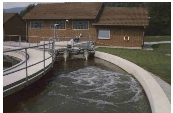
Montage sur passerelle
