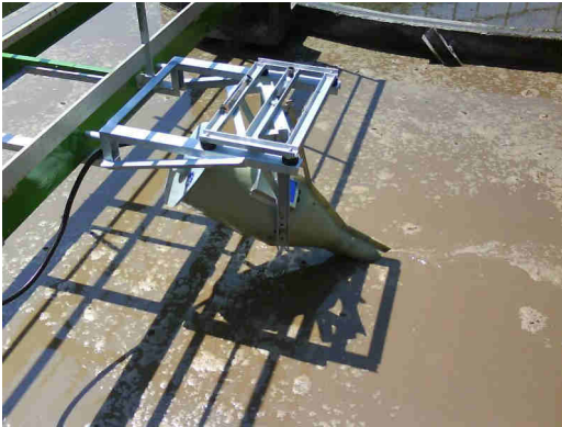
Remplacement de pont brosse
