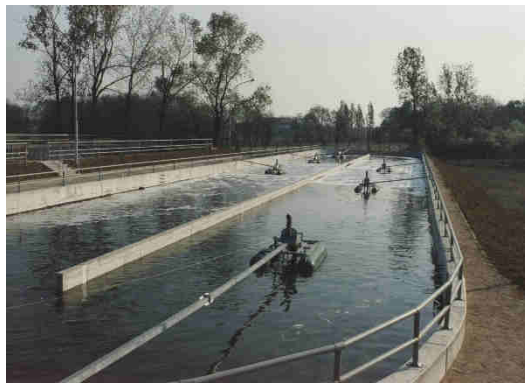
Installation en chenal
