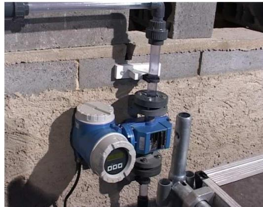
Figure 4. Débitmètre pour la gamme 0.54 – 18 m<sup>3</sup>/h
