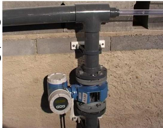
Figure 3. Débitmètre pour la gamme 5.4 – 180 m<sup>3</sup>/h
