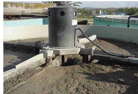
Montage sur flotteurs
