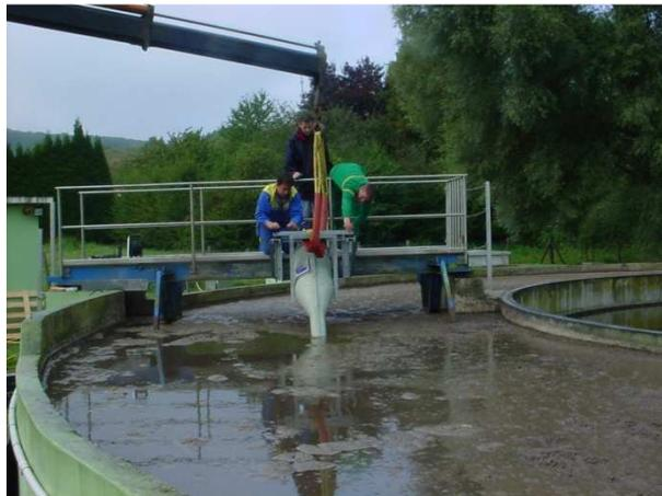
**Opération n° 10 :** Régler l'angle d'orientation de l'aérateur dans le chenal
