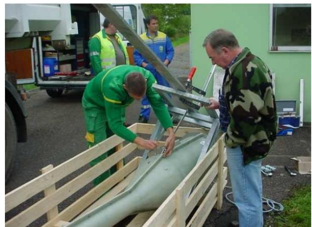
**Opération n° 8 :** Fixer solidement l'aérateur à l'aide d'une sangle à l'engin de levage et le présenter sur la passerelle
