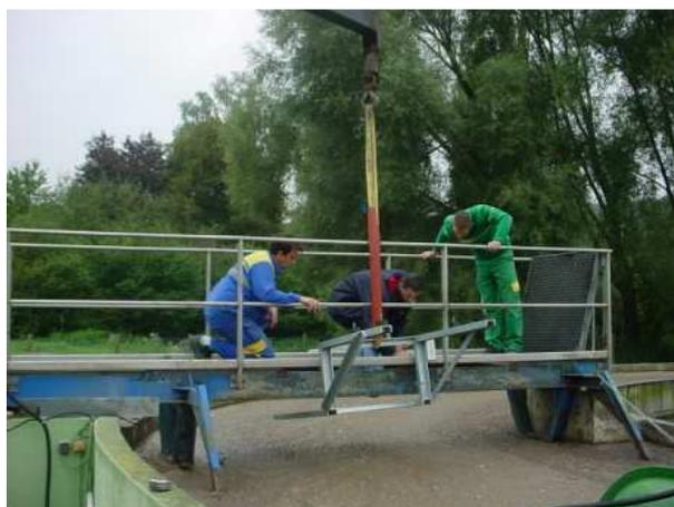
**Opération n° 3 :** Fixer le cadre sur la passerelle à l'aide des 4 griffes de fixation
