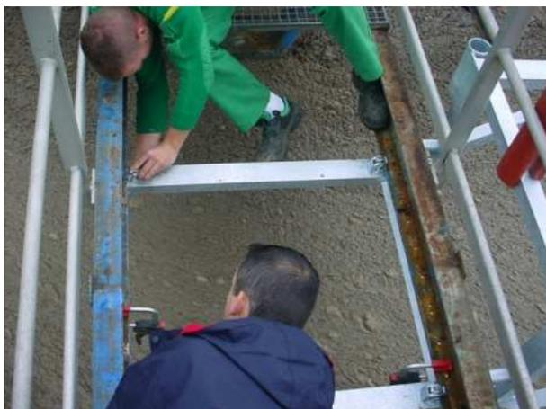
**Opération n° 4 :** Percer 2 trous Ø 16 au niveau des entretoises pour stabiliser le cadre (supprime les éventuelles vibrations), ce sont les seuls trous qu'il y aura à percer pour cette opération
