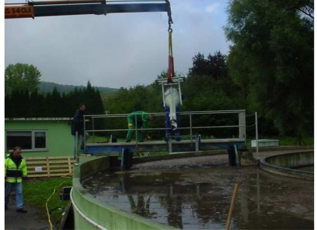
**Opération n° 9 :** Fixer l'aérateur sur les 4 silentblocs
