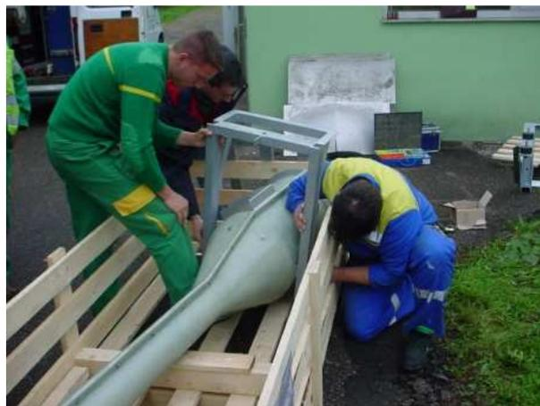
**Opération n° 6 :** S'assurer du montage correct de la fourche de suspension (cf. schéma d'installation)
