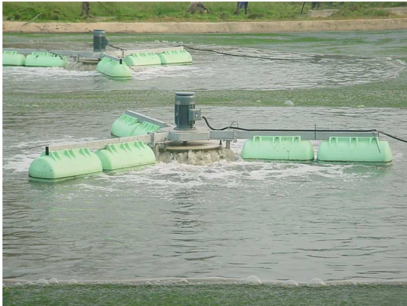
Aérateur Centrox CX 15 kW installé sur suspension flottante
